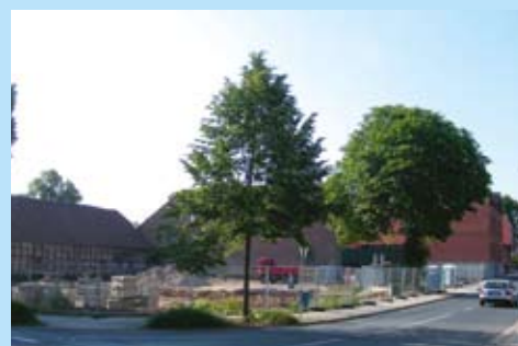
Hier entsteht der neue NP-Markt.
